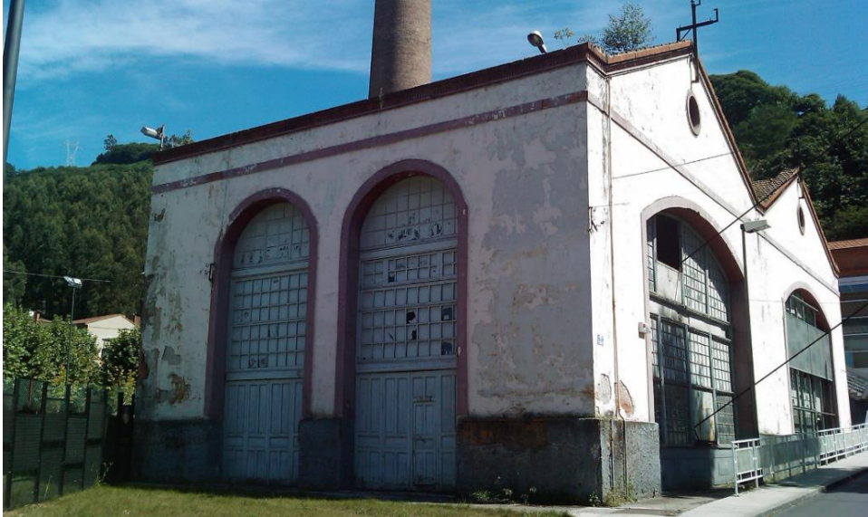
Figura 20. Edificio de Maquinaria de Extracción del pozo Barredo.
